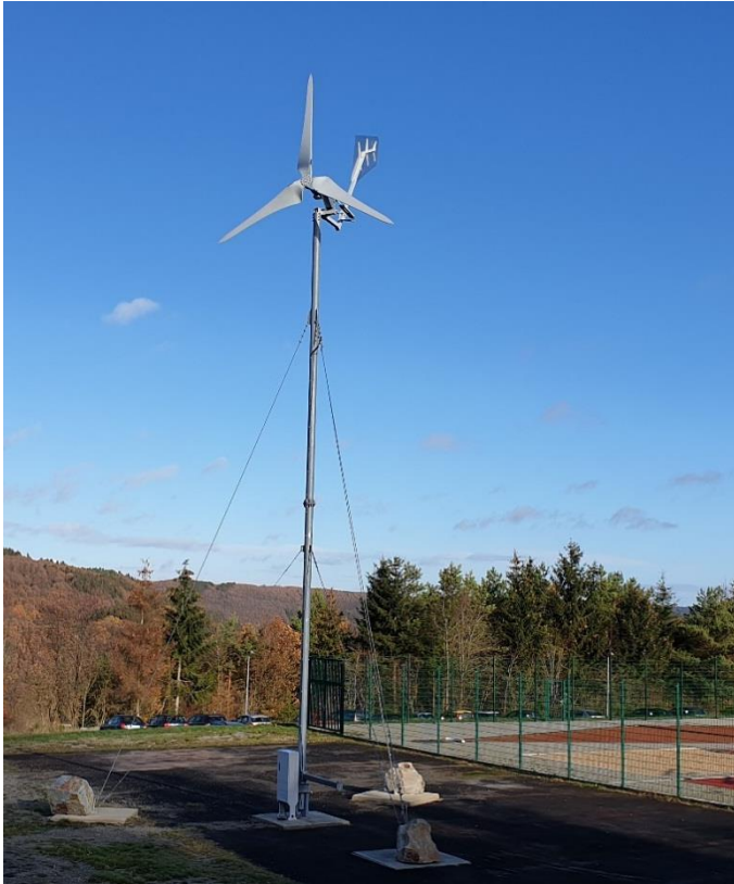
Blick auf die CFS-Kleinwindanlage neben dem Waldstadion
